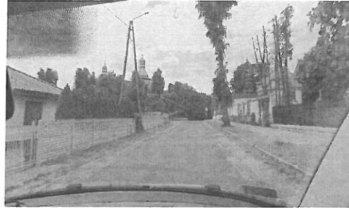
odcinek drogi w km 0+460
