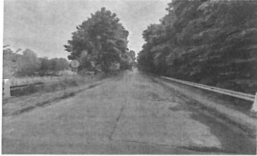
jezdnia w okolicach obiektu mostowego
