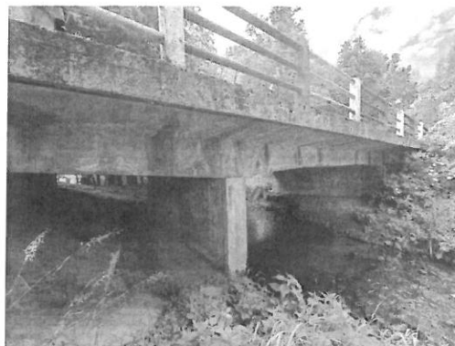
przebudowywany obiekt mostowy
