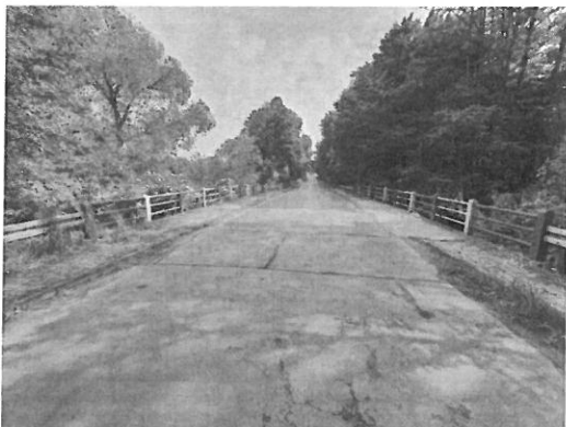
widok na obiekt mostowy
