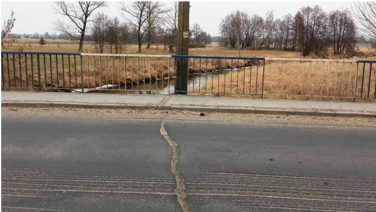
Fot. 1 Nawierzchnia na jezdni i chodniku (chodnik od strony dolnej wody)
