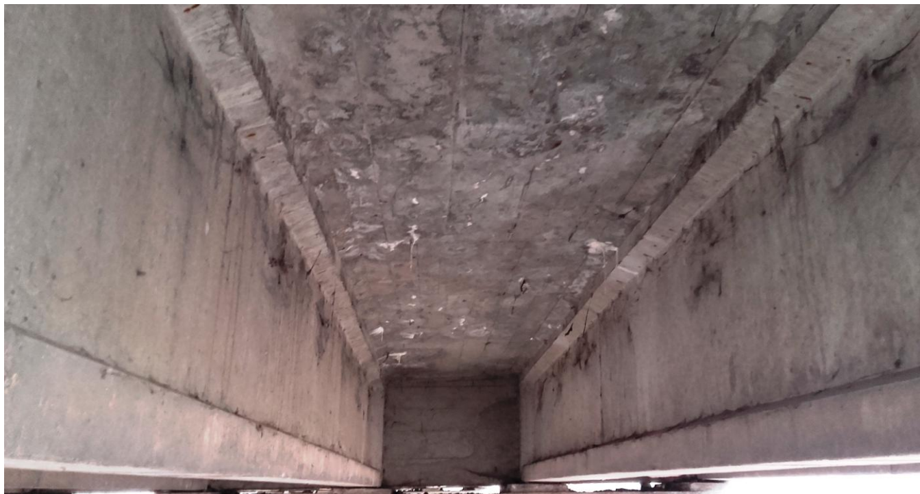
Fot.5 Widok od spodu płyty pomostowej i belek sprężonych połączonych z poprzecznicą
