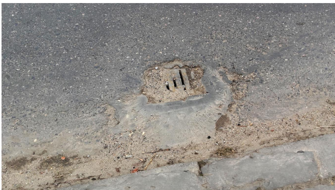
Fot. 4 Widok wpustu ulicznego odwadniającego nawierzchnię od strony górnej wody
