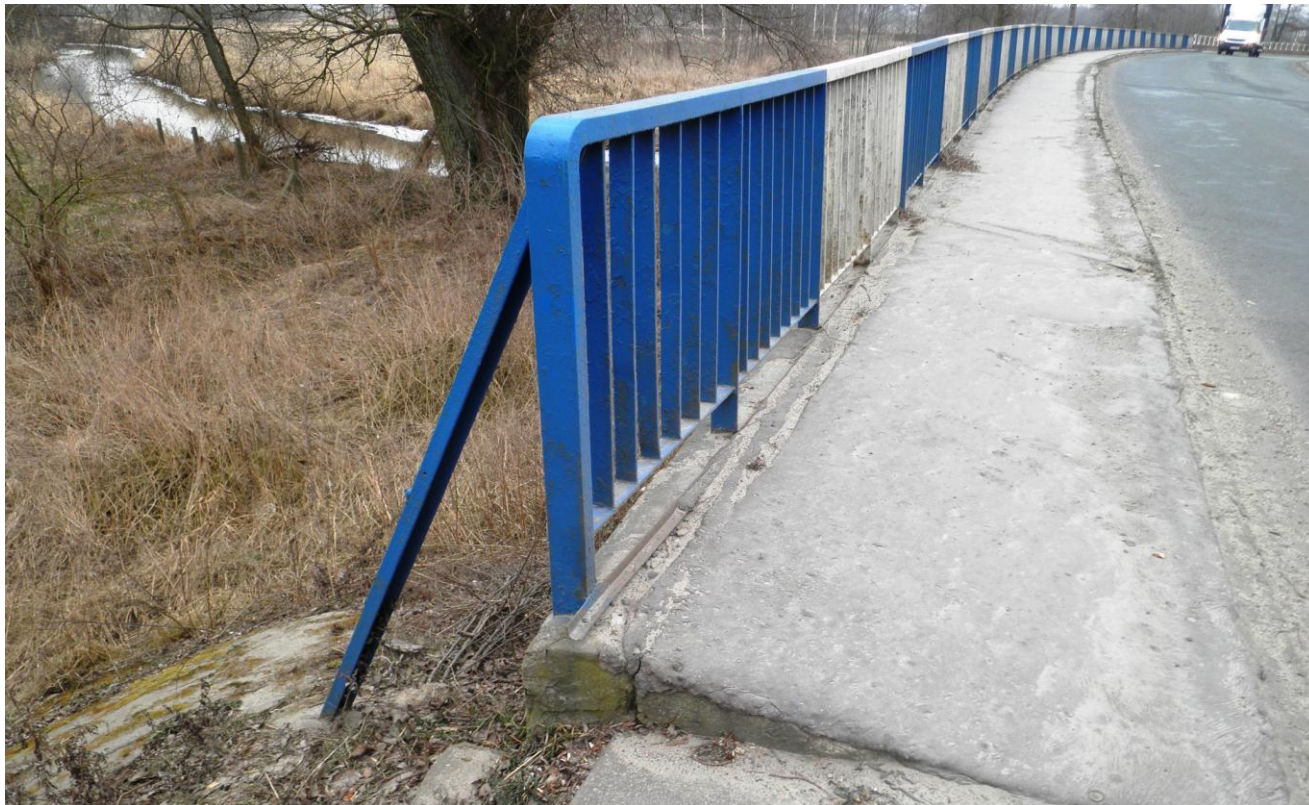
Fot. 3 Barierki osadzone w belkach podporęczowych na przyczółku
