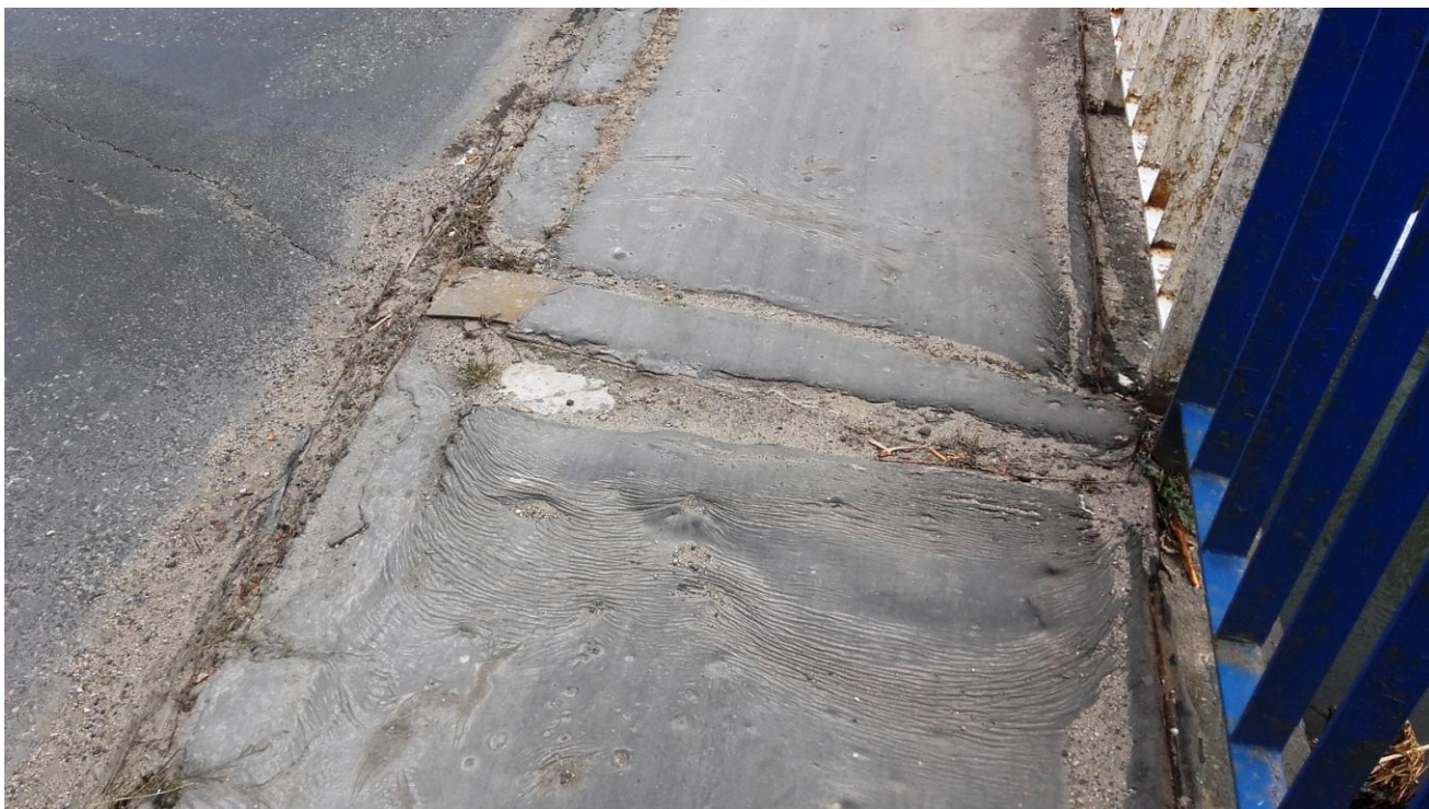
Fot. 2 Nawierzchnia na chodniku i dylatacja (chodnik od strony górnej wody)
